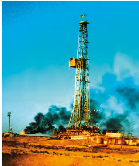
Tiefbohrarbeiten mit der Bohranlage 3 DH - 250 B im Jahr 1987 in Nord-Rumaila
