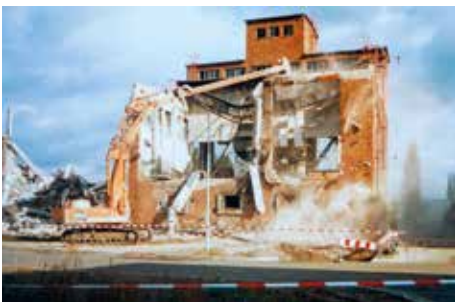
ABM-Einsatzbetrieb: Abriss des Gesamtgebäudes des Heizwerkes
