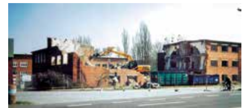
Abriss des Hauptgebäudes in 2009
