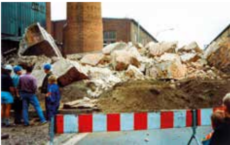
ABM-Einsatzbetrieb: Abriss des 1. Schornsteines des Heizwerkes am 21.08.1993
