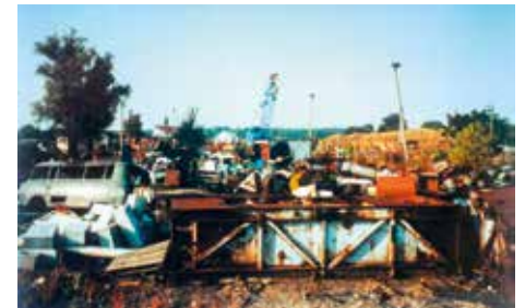
ABM-Einsatzbetrieb: Beräumung von Schrott und Demontage nicht mehr benötigter Ausrüstungen
